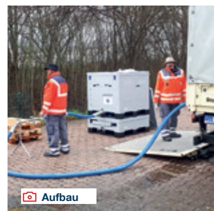
Aufgebaute Trinkwasser-Entnahmestelle
