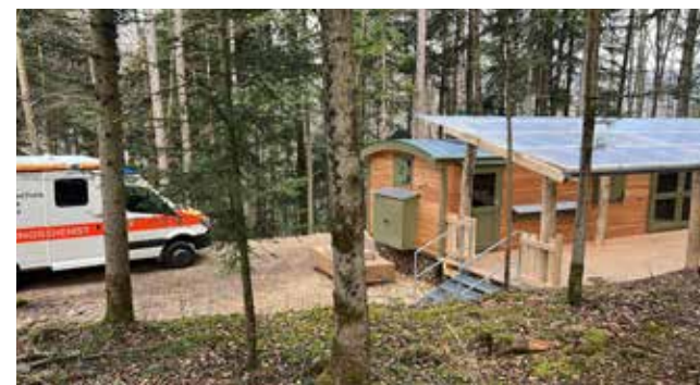
Rettungswege werden überprüft
